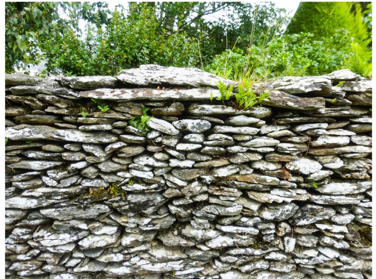
▲ Mur de pierres sèches en schistes de La Vilaine, les tailleurs de pierre débitent les schistes en pierres plates en exploitant le plan de schistosité qui est aussi un plan de débit privilégié. Tumiac
